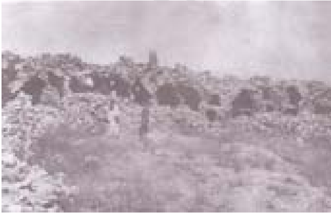
شكل 38 الفناء الداخلي لقصر التخزين المعروف بقصر سيدي حامد
