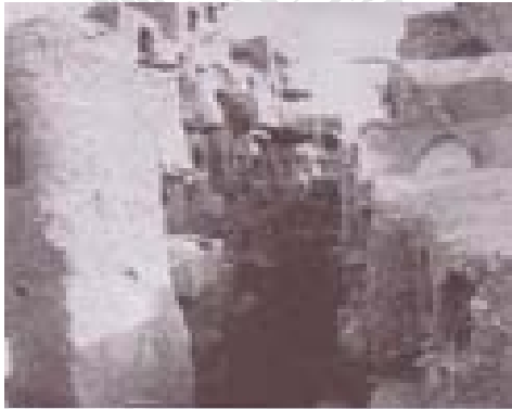
شكل 8 جزء من الممر الذي يحيط بالمبنى الداخلي لقصر التخزين بناولت
