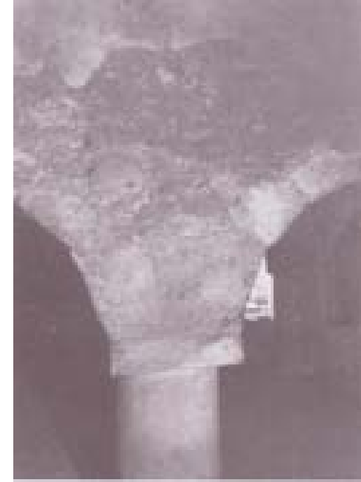
شكل 178 لقطة لعمود من الأعمدة الموجودة بقاعة الصلاة لمسجد الكنيسة
