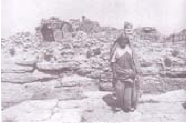
شكل 37 جزء من الخندق حول قصر التخزين المعروف بقصر سيدي حامد
